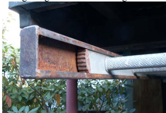
Rörliga stegbenen omsluter stegen.
